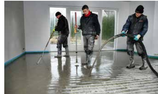
eco2floor geeft veel minder overlast op de bouw, heeft een lage krimp, is na circa 24 uur beloopbaar en na circa 72 uur al belastbaar.
